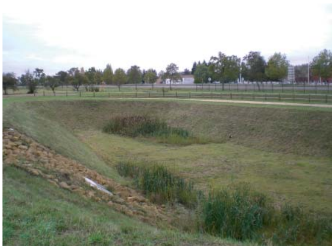
Bassin de rétention
