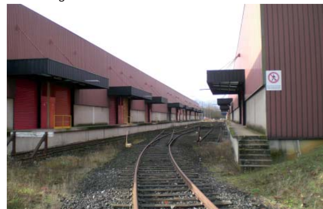
Quai de chargement Eurotransit
