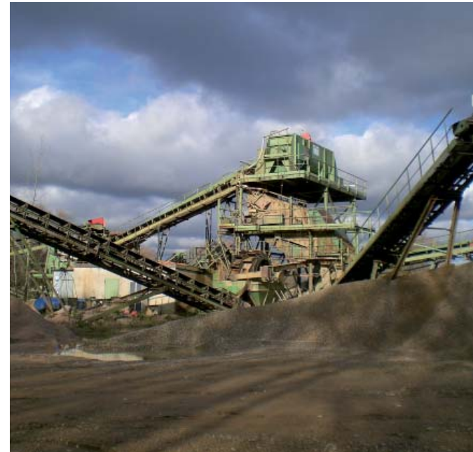
Extraction du sable sur le ban d'Ennery
