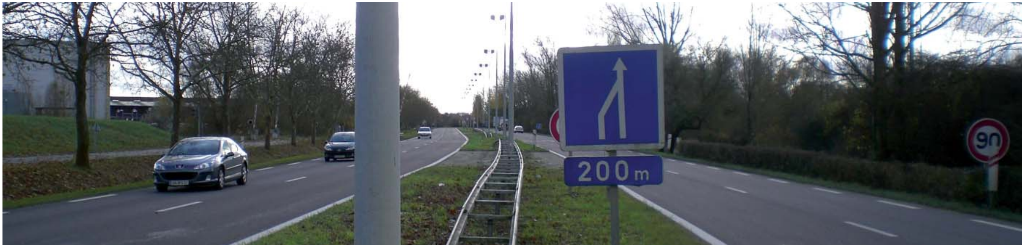
Route départementale n°1 en 4 voies
